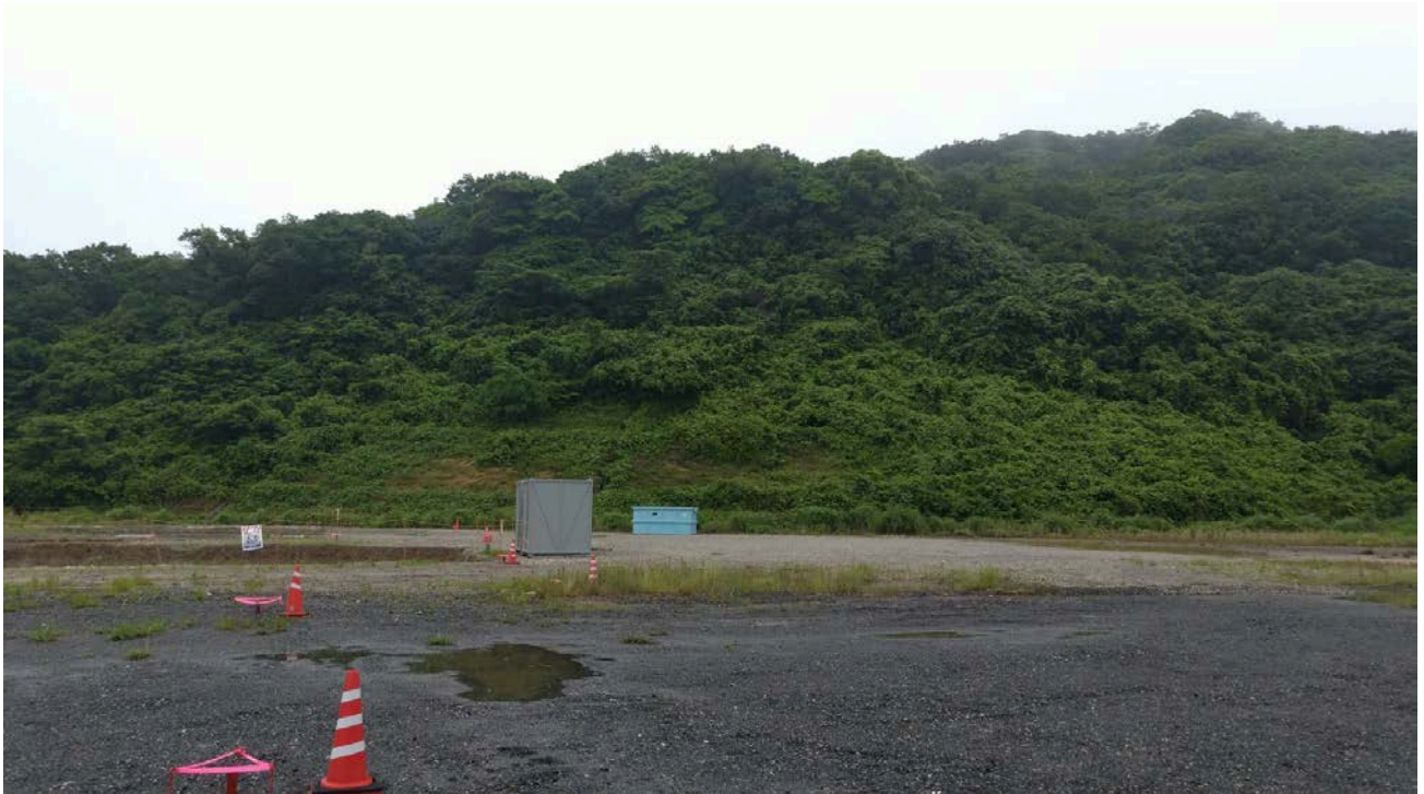
小野田・楠企業団地内の山陽小野田グリーンエネルギー発電所の建設予定地。
